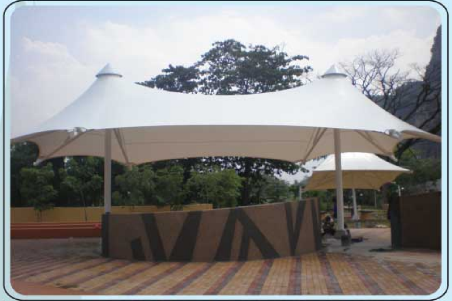
Majlis Perbandaran Selayang
