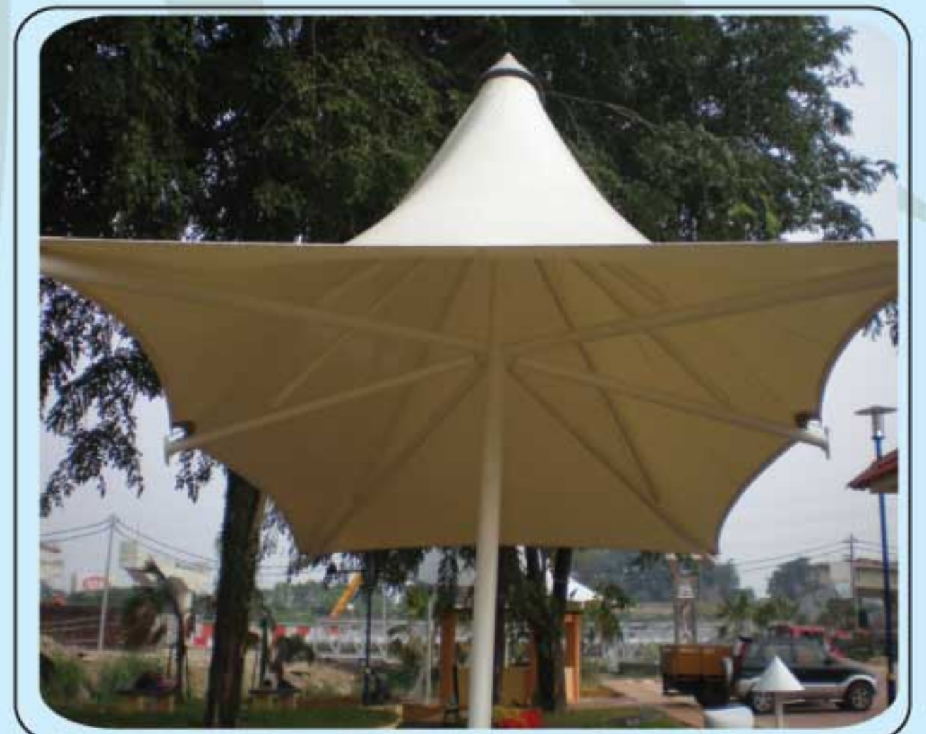
Majlis Perbandaran Selayang
